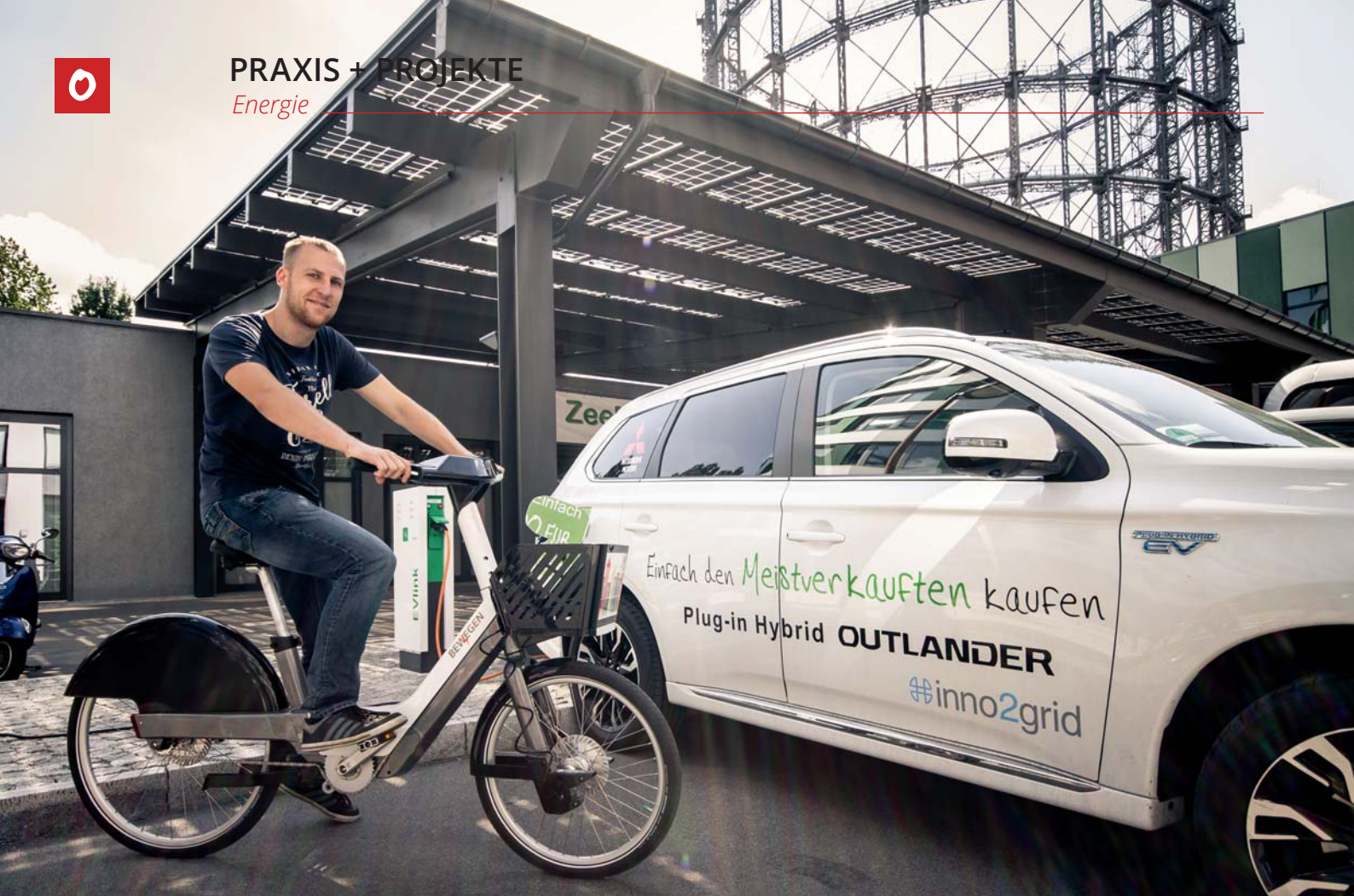
Bild 1: Solarcarport für grüne E-Mobilität. Mit insgesamt drei Photovoltaikanlagen werden im Micro Smart Grid rund 80kWp Leistung zur Verfügung gestellt. © Vipul Toprani
